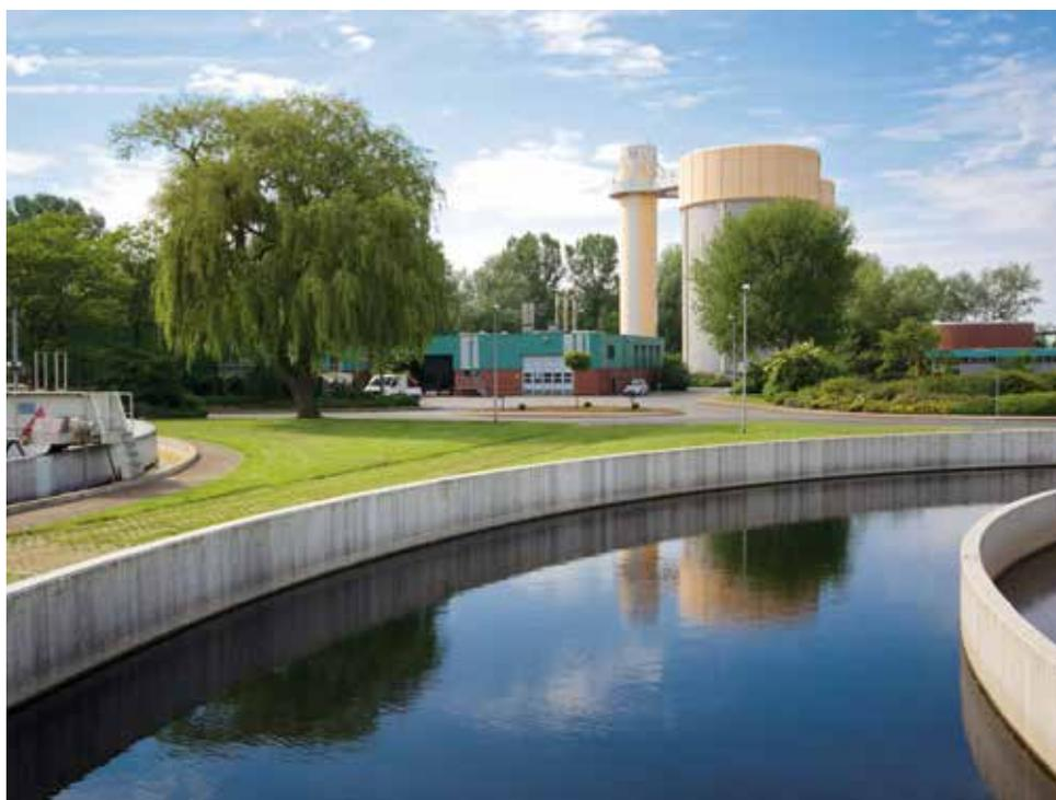
Eine der herausragenden Stärken der Zentralkläranlage ist ihre Energieautarkie. Dank der Rückgewinnung von Energie aus Klärgas und der Nutzung von modernen Blockheizkraftwerken betreibt die BEG die Anlage seit 2015 wärme- und stromautark. In vielen Städten sind die Kläranlagen der größte kommunale Energieverbraucher – nicht so in Bremerhaven.
